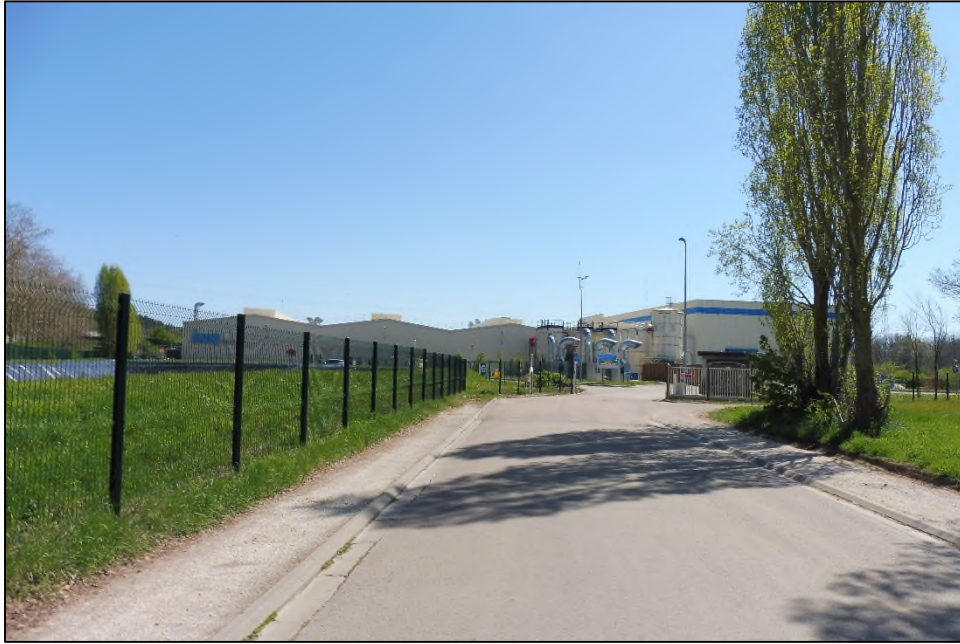
Vue depuis la voie de desserte du site
