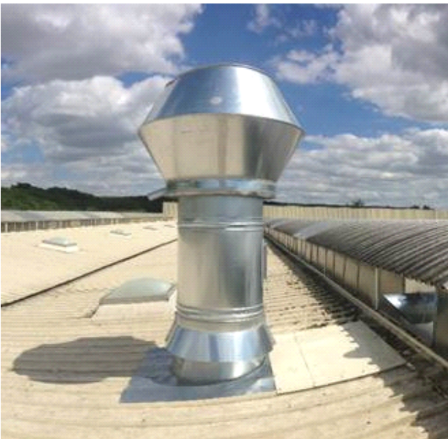
Cheminée centrale A1
