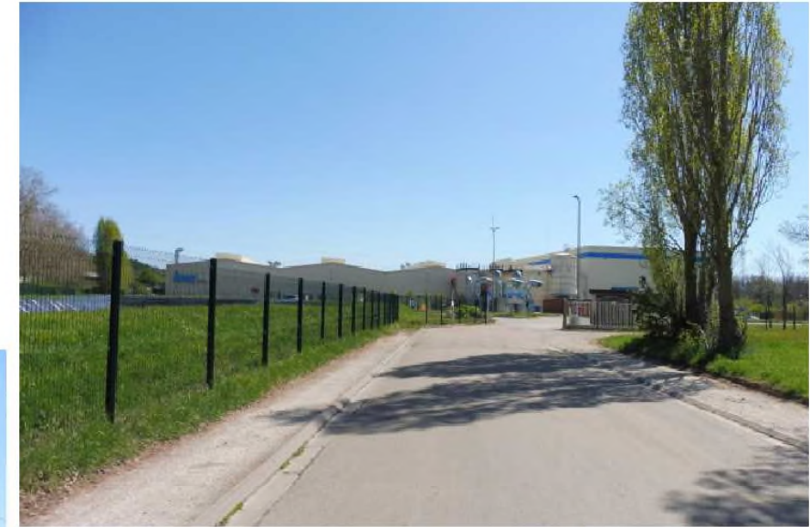
2 – Vue Ouest, depuis la voie d'accès au site
