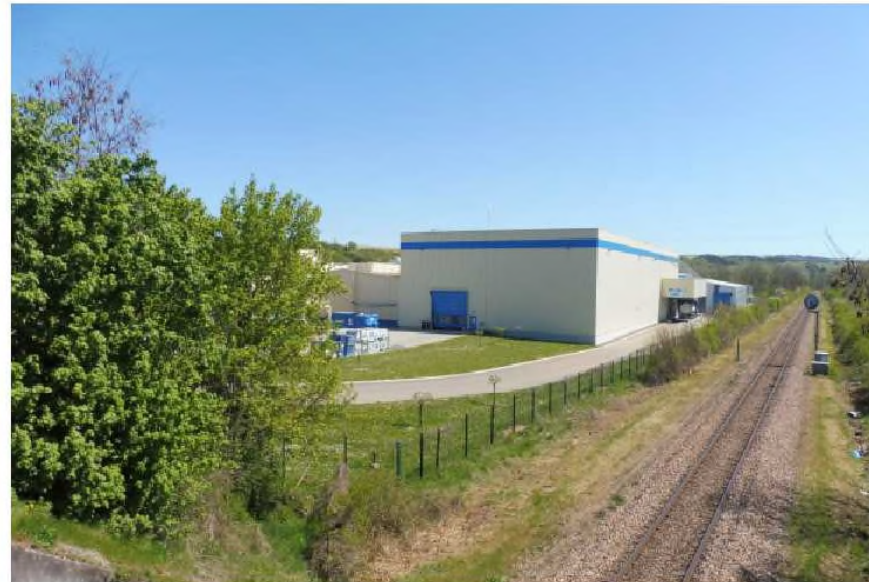
3 – Vue Ouest, depuis le pont de la voie ferrée
