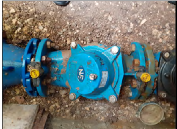
Disconnecteur sur l'alimentation d'eau de ville
