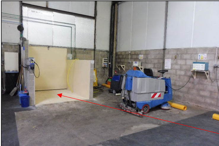
Zone vidange autolaveuses
