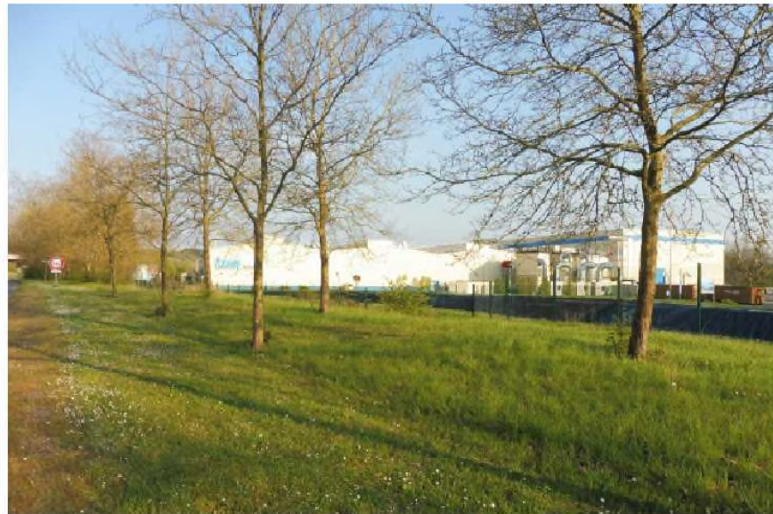
1 – Vue Nord-Ouest, bordure RD606
