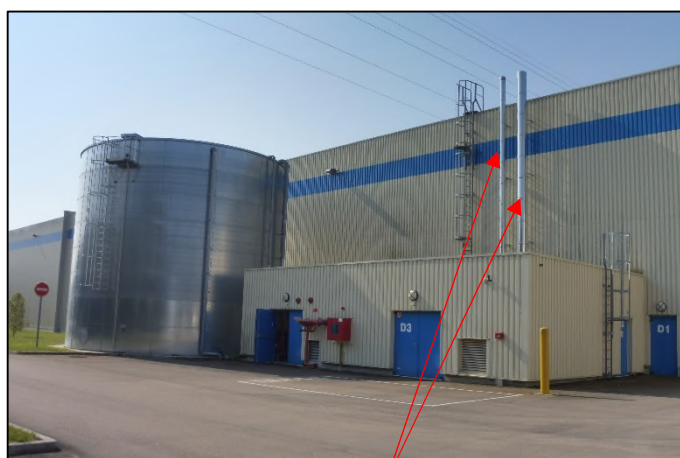
Cheminée A4a / A4b
