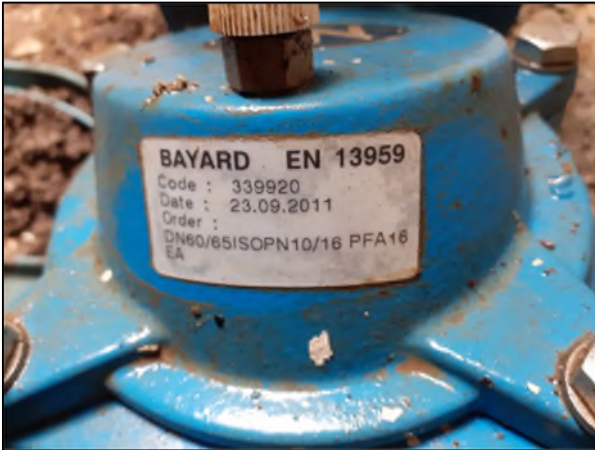
Disconnecteur sur l'alimentation d'eau de ville
