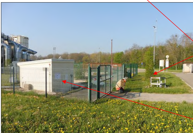
Emplacement future cuve rétention
