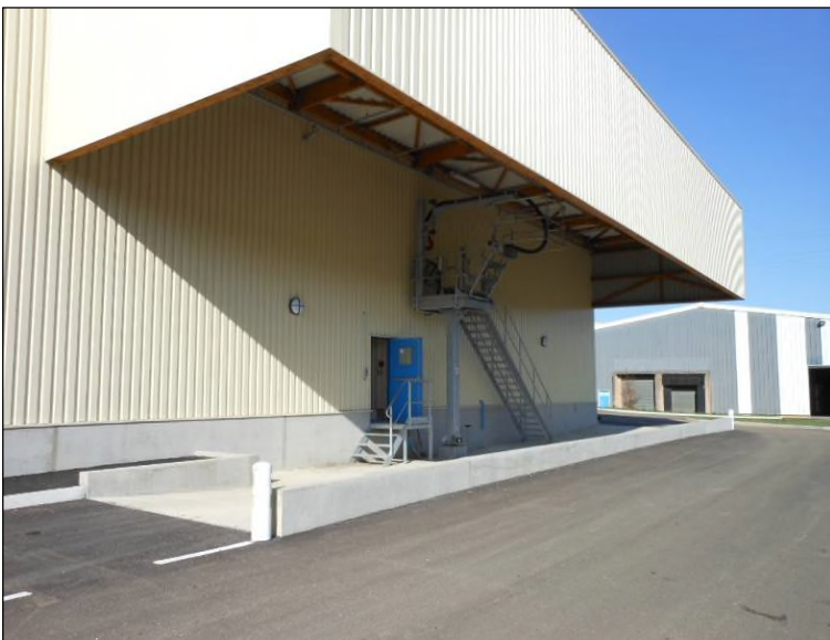
Aire dépotage PMDI – Façade Sud
