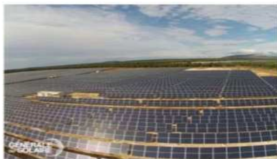
Centrale de Belvezet, Gard
