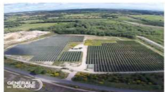
Centrale de Pujot, Gard
