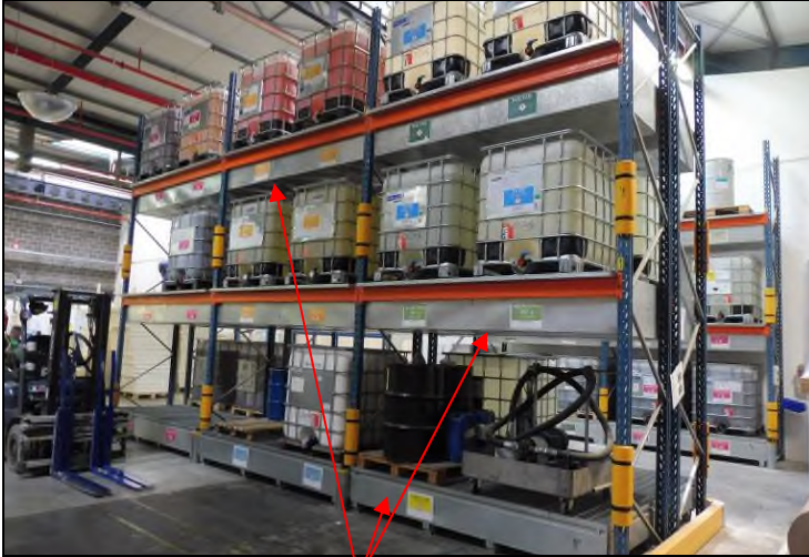
Bacs rétention IBC – zone B'
