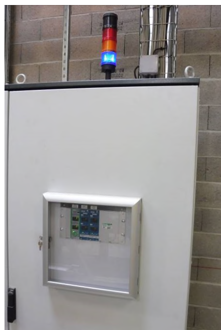
Centrale détection – ligne PU-B
