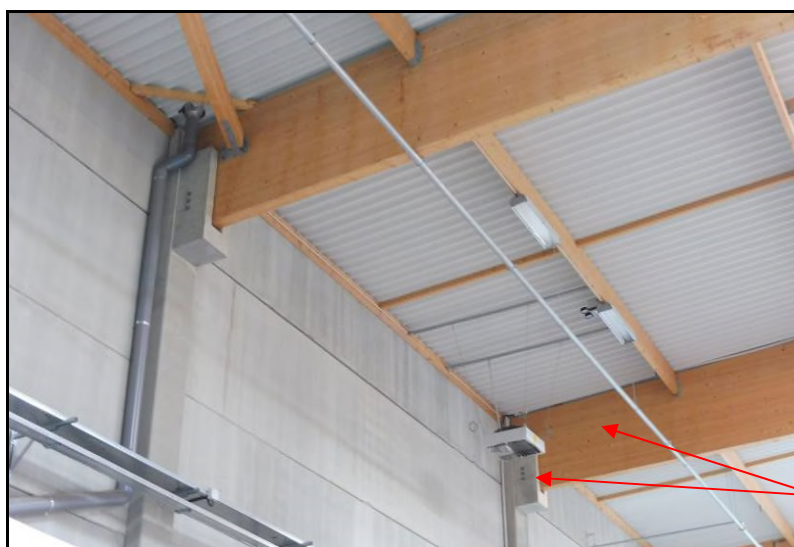
Poteaux béton / charpente lamellé-collé des halls de stockage
