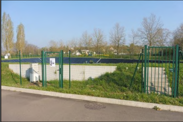
Bassin de confinement Nord
