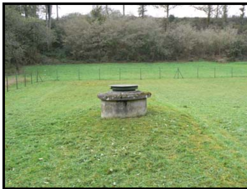
Puits de captage des Prés Tardifs
