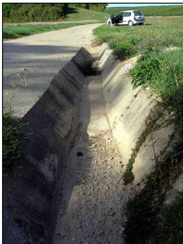
Photo 4 : Exutoire de type canal bétonné ouvert, à Chablis
