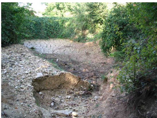
Vau de Passy, bassin de rétention, les gens se servent en terre sur le site.
