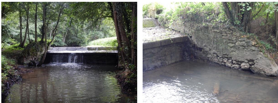
Fig. 4. Vue aval du déversoir et du bajoyer rive gauche
