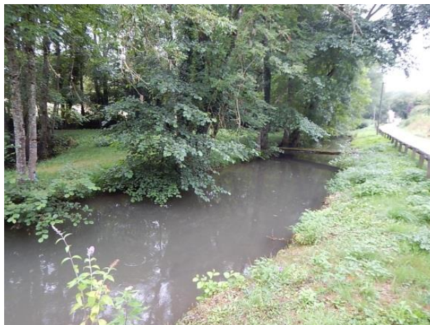
Fig. 6. Condition d'accès à l'ouvrage amont
