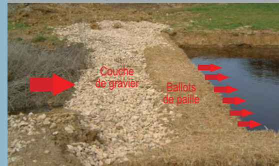
Exemple de dispositif filtrant
