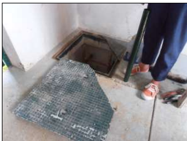
Figure 4 : réservations présentes sur le radier du bâtiment
