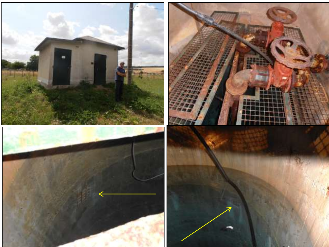
Figure 3 : clichés du captage
