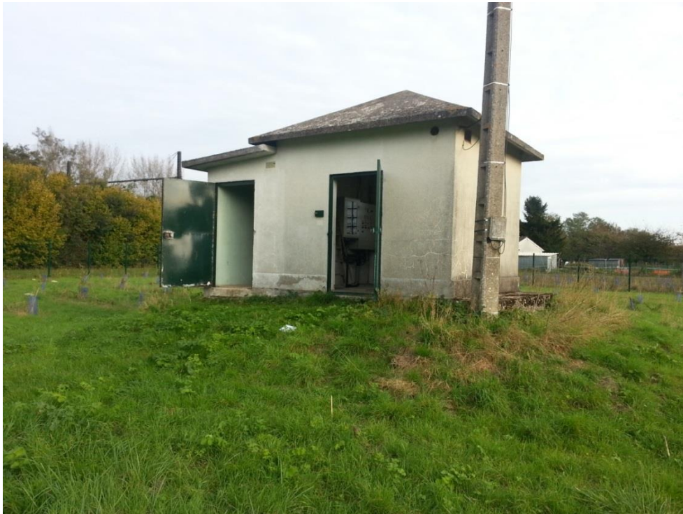
Figure 3-1 : Vue du bâtiment d'exploitation présent sur la parcelle (source : SAFEGE, 2014)
