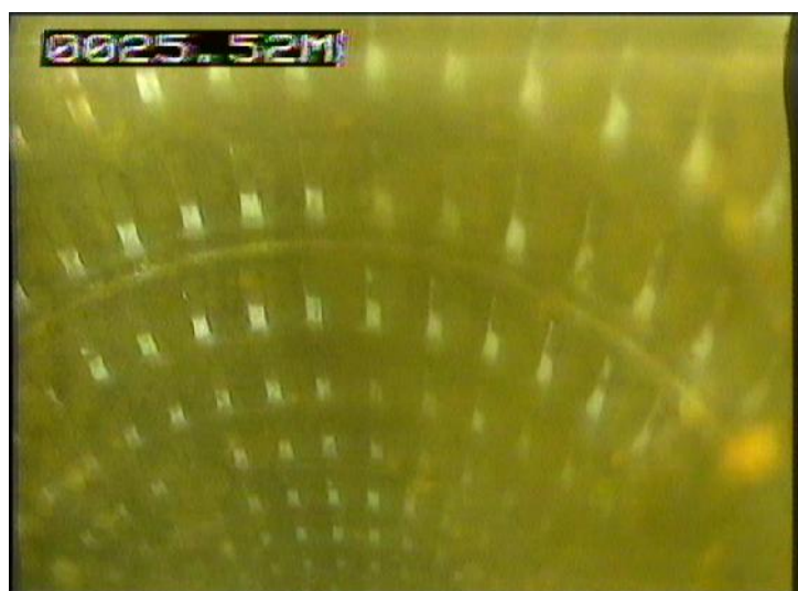
tubage concrétionné
