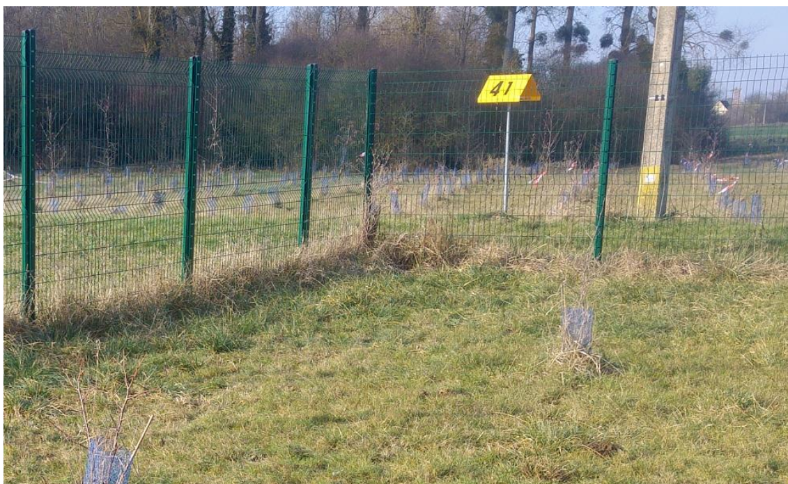
Figure 7-10 : Photographie d'un panneau-repère de la conduite de gaz longéant la clôture du captage des Prés Clos.
