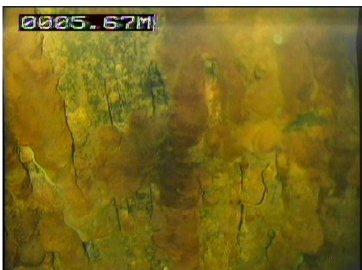
Crépines et massif filtrant
