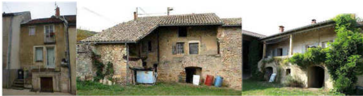
Photographie de diverses maisons vigneronnes issues des diagnostics des AVAP de Fontaine-Lés-Dijon (à gauche) et Chasselas (centre et droite).
