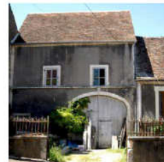
Maison vigneronne du Nivernais : maçonnerie enduite, encadrement et arc en anse de panier 2 mis en valeur grâce à un changement de teinte de l'enduit, mise en valeur de la clé (pierre du sommet de l'arc). Source : CD-Rom Observer Comprendre Restaurer, CAUE ET MAISONS PAYSANNES DE LA NIEUVRE.
