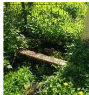
Figure 8 : exutoire du trop-plein NW
