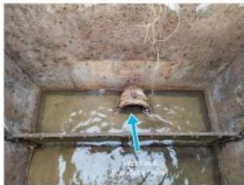
Acheminement de l'eau vers l'aval par une conduite fonte DN 150
