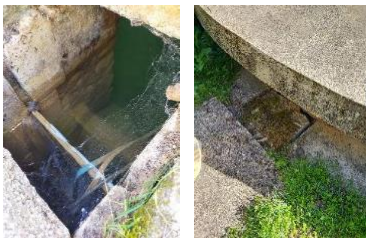
Figure 9 : trop-plein situé au SO du puits : canal avec batardeau
