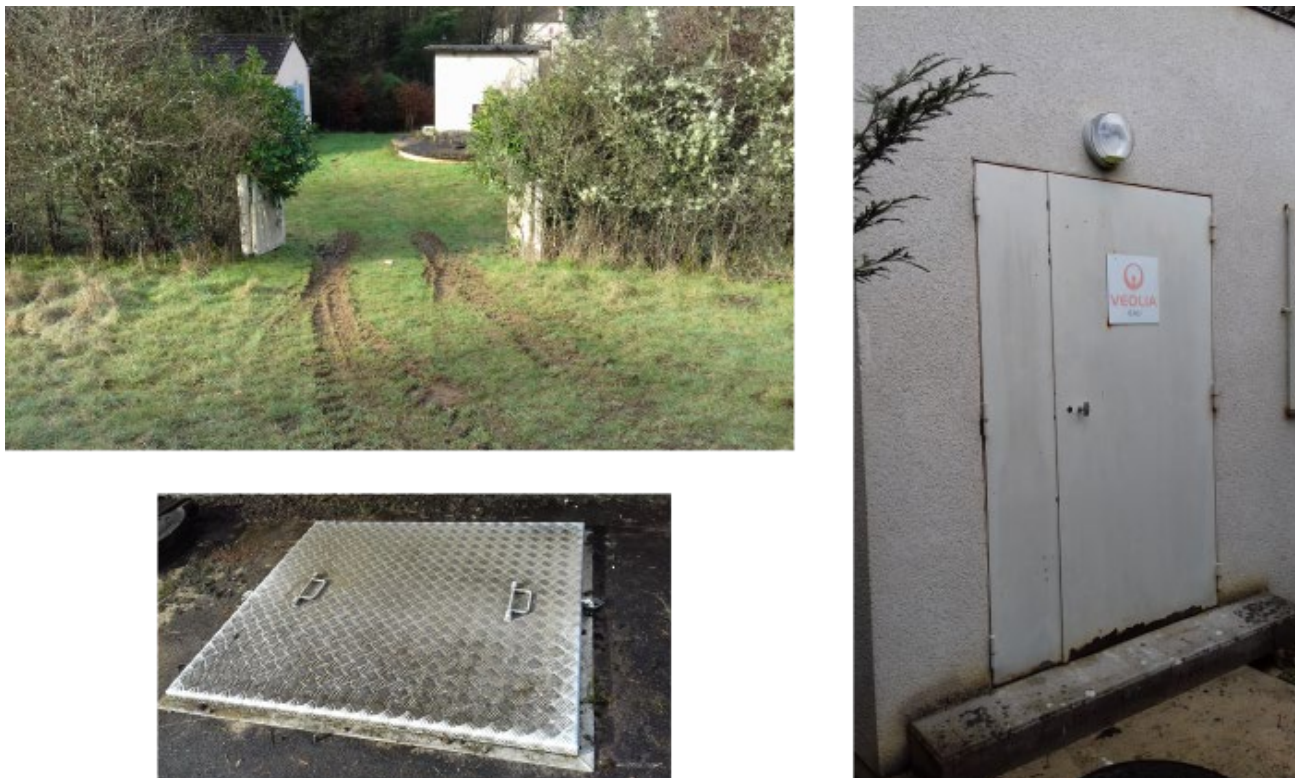
Figure 6 : Accès au captage en 2018 en haut à gauche, fermeture du captage en bas à gauche, accès à l'unité de traitement à droite
