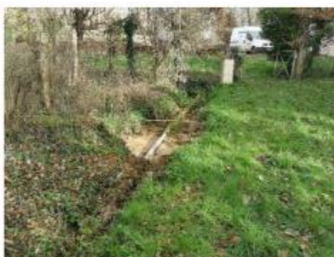
Conduite fonte ou acier (?)
