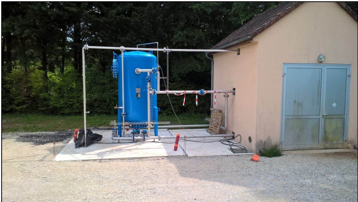
Figure 33 : Unités de traitement à gauche, traitement des pesticides, unité en construction en 2018 ; à droite, unité de traitement de la turbidité
