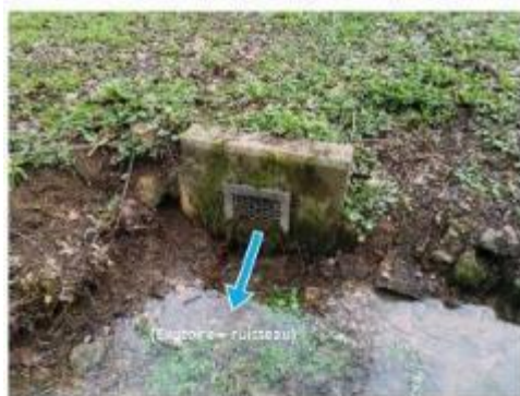
Sortie/ exutoire de la conduite fonte DN 150 depuis le canal avec batardeau.
