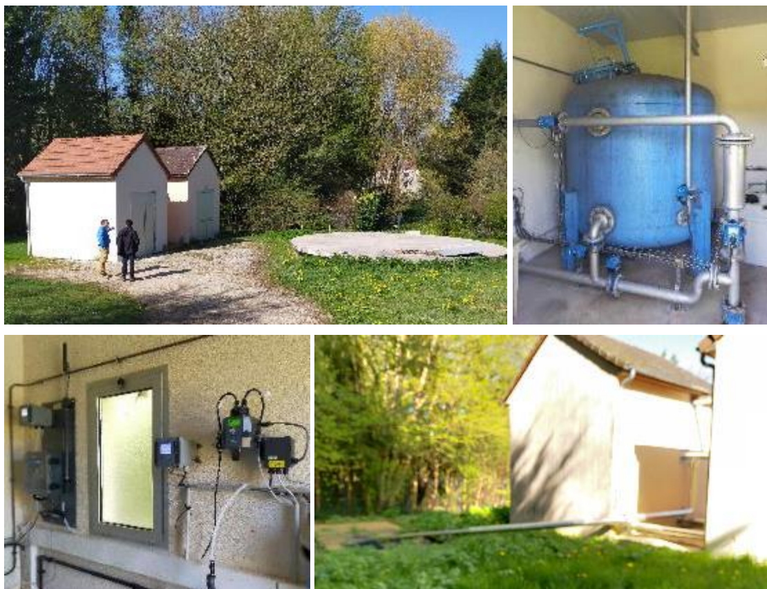
Figure 11 : traitement des eaux du captage : le filtre à sable, les débitmètres et le bassin récepteur des eaux de lavage
