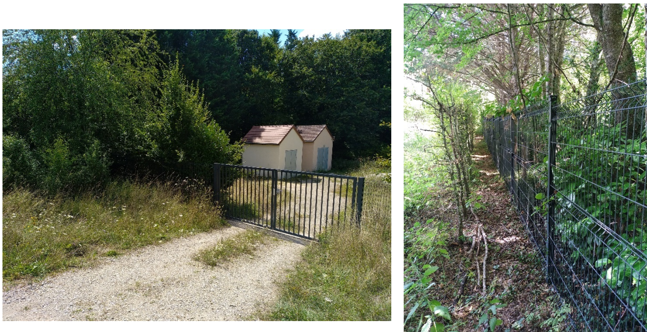
Figure 6bis : Accès au captage en 2023 à gauche, clôture à droite
