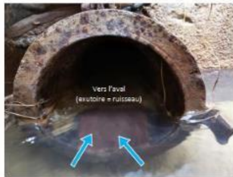
Acheminement de l'eau vers l'aval par une conduite fonte DN 150
