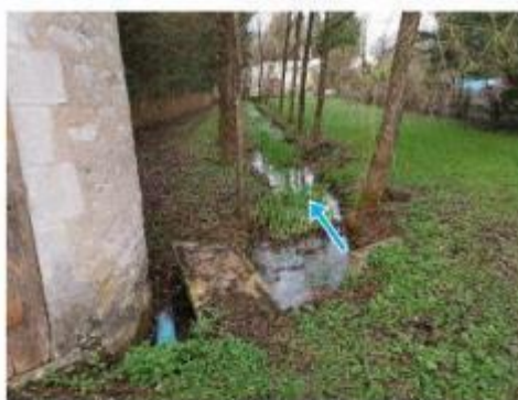
Sortie/ exutoire de la conduite fonte DN 150 depuis le canal avec batardeau.
