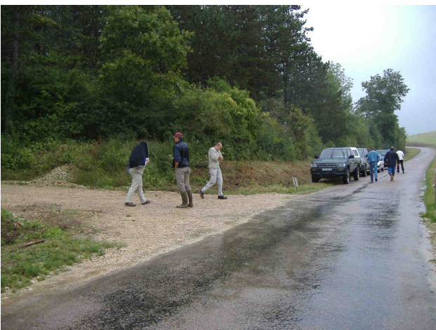
D139, route susceptible d'être coupée par les eaux de ruissellement avec apport de cailloux
