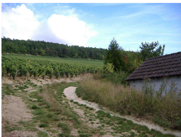
Fye (68) rigole de protection des habitations et exutoire sur route du village
