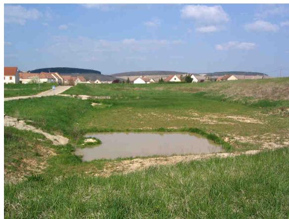
Vallée Valvant (78), aménagement de protection du lotissement
