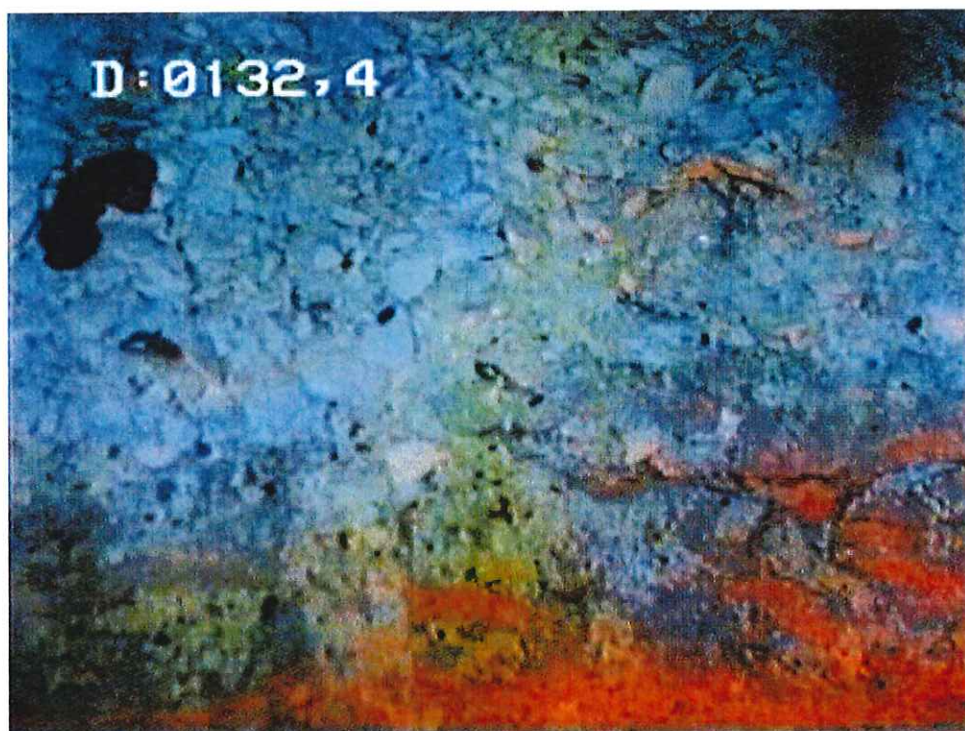
17- Réduction de diamètre – passage en foration 311 mm
