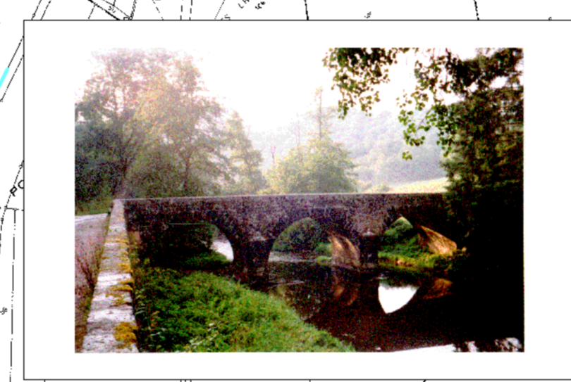
Pont de la RD75 Sbv = 265,98 km 3 P10 = 64 mm/jour Q10 = 56 m 3 /s Q100 = 112 m 3 /s
