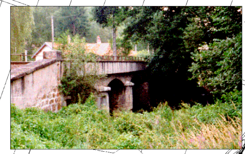
Pont du MELUZIEN. Cet ouvrage n'a encore jamais été mis en charge lors des crues historiques.
