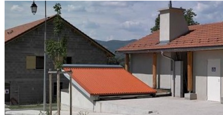
Chaufferie bois La Rivière (38)
