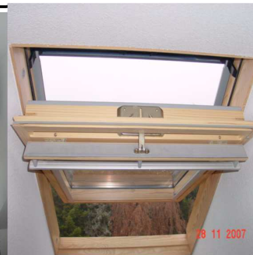
Absence d'entrée d'air dans pièce principale
