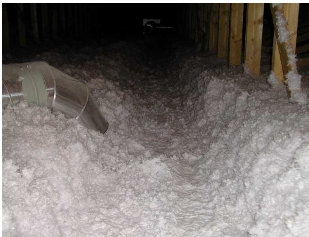
Absence d'isolant dans combles
