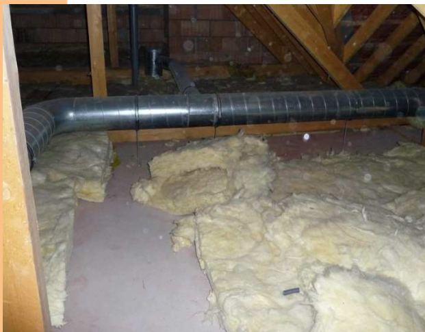
Absence d'isolant dans combles
