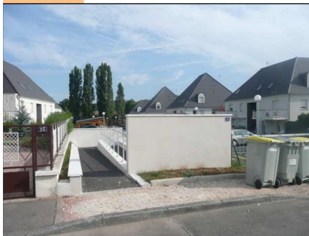
Éclairage extérieur insuffisant ou absent
