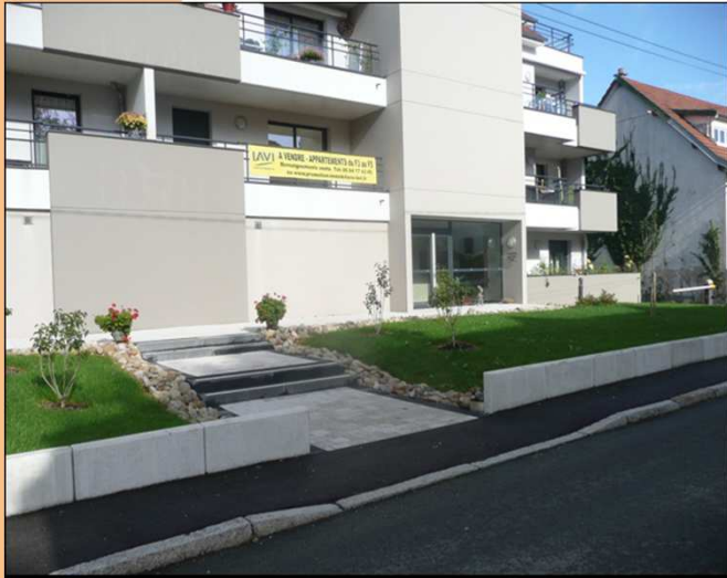
Absence de continuité de la chaîne du déplacement avec l'extérieur du terrain
