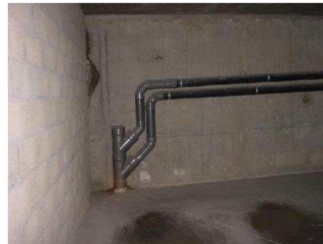
Protection des conduits et gaines
