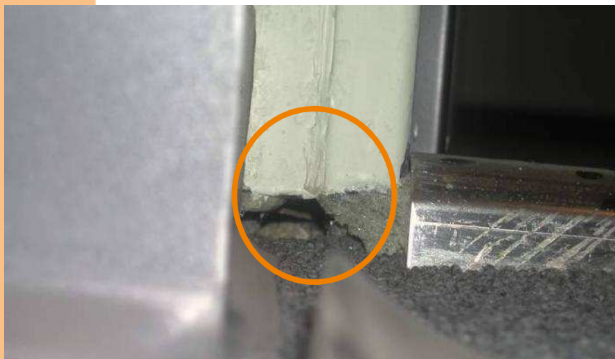
Communication entre la circulation commune et le logement par un espace sous la porte
