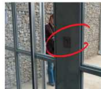
4. Gâche électrique et poignée de la porte difficilement repérables par manque de contraste.
