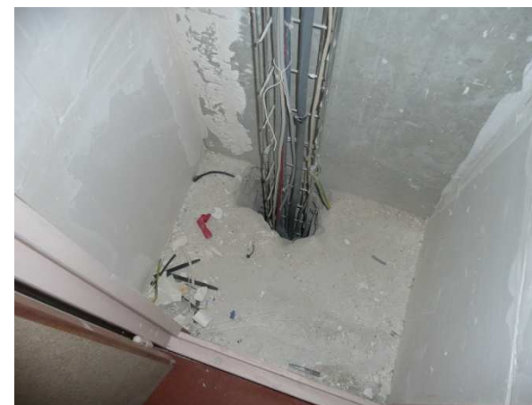
Recoupement gaine technique
