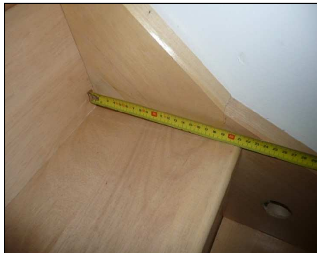
Hauteur et giron de marche / Débord excessif
