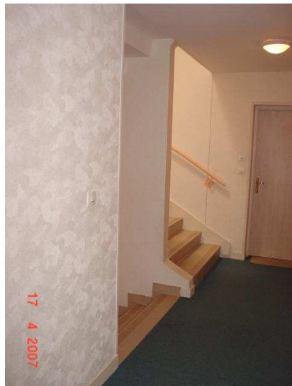
Escalier non encloisonné (2ème famille > à 8m)
