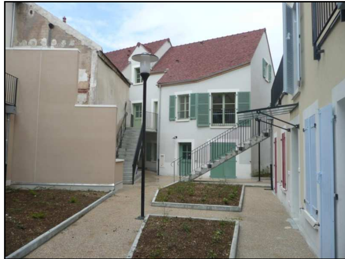
Absence de signalétique facilitant le repérage
