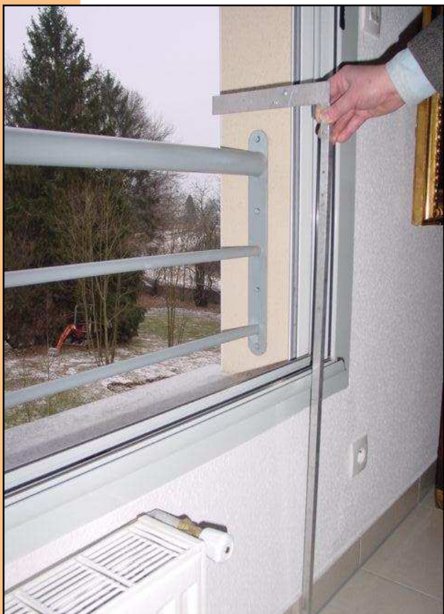
Fenêtre avec barre d'appui < 1 m de hauteur
