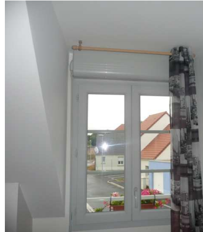
Absence d'entrée d'air dans pièce principale
