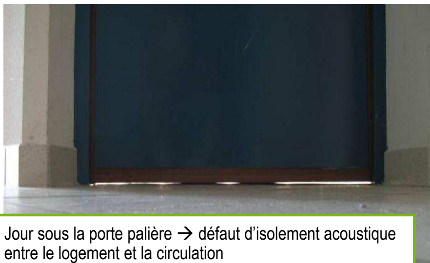
Communication entre la circulation commune et le logement par un espace sous la porte
